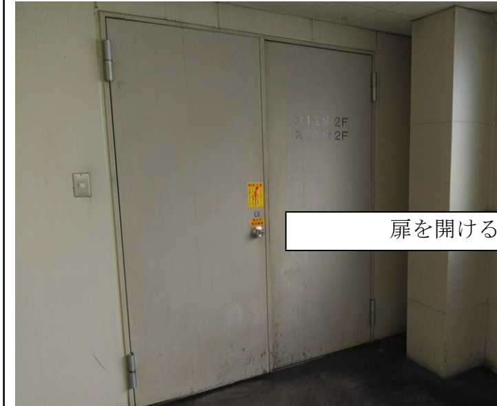
通路側から見た扉 (改善前)
