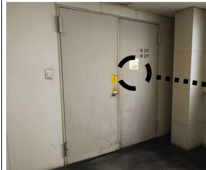
通路側から見た扉 (改善後)
